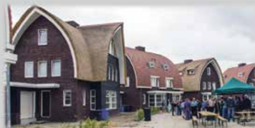
Dalemburgh te Gorinchem – nieuwbouw van 36 villawoningen
