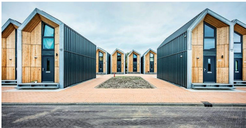
Verplaatsbare woningen, bron: Volkskrant https://www.volkskrant.nl/nieuws-achtergrond/duizenden-verplaatsbare-woningen-ingezet-in-strijd-tegen-woningtekort~b98e16d6/
