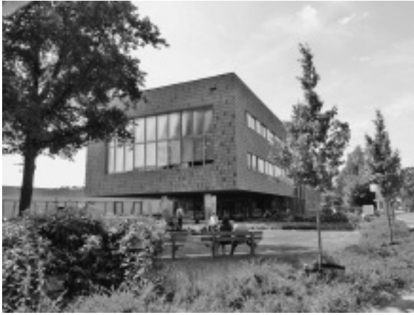
Het gebouw van de Inclusief Groep in Nunspeet
